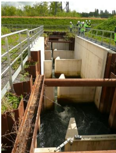
Figuur 22: Bekkens van de vispassage in Straatsburg
