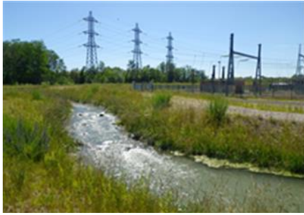
Figuur 24: Rivier voor stroomopwaartse vismigratie om de centrale heen in Straatsburg
