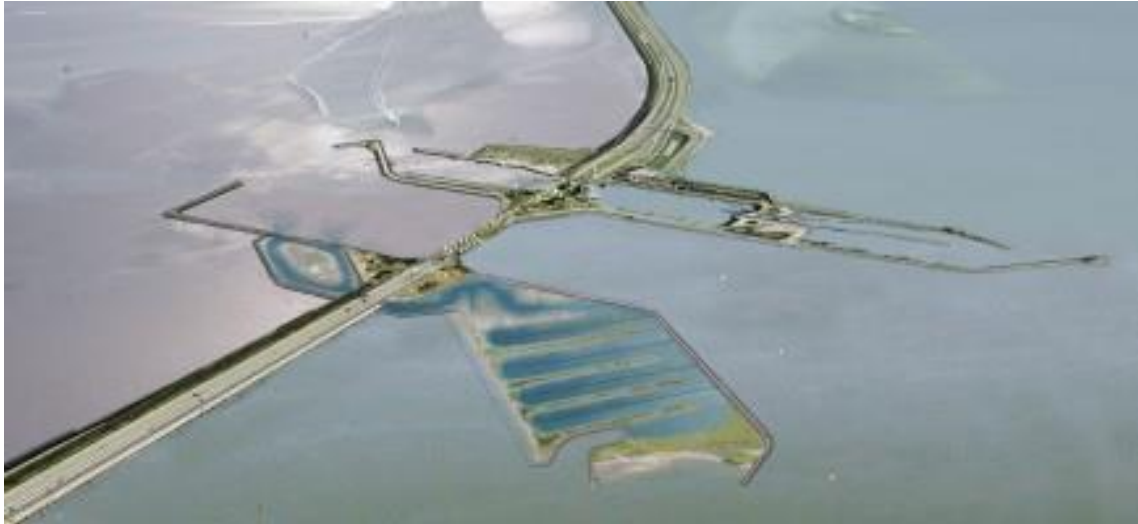
Figuur 14: Vismigratierivier Kornwerderzand (ontwerp)
