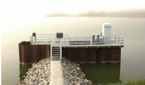
Figuur 10: Uitzwembak met de pomp in het IJsselmeer
