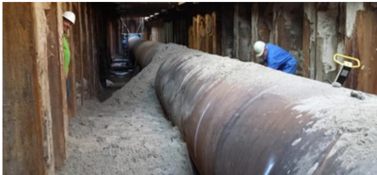
Figuur 9: Indruk van de omvang van de leiding (diameter 1,5 meter)
