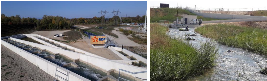
Figuur 25: Vispassage in Gerstheim. Foto's: EDF
