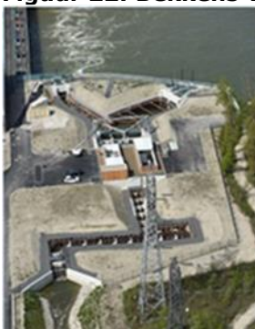
Figuur 23: Ingang van de vispassage in Straatsburg en lokstroming
