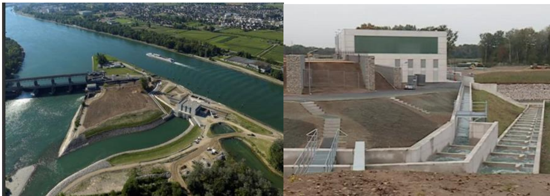
Figuur 30: Stuw en vispassage in Kembs/Märkt. Links: stuw in Kembs/Märkt; Elzaskanaal en oude loop van de Rijn. Rechts: stroomopwaartse vismigratievoorzieningen aan de stuw in Kembs/Märkt. Foto: EDF
