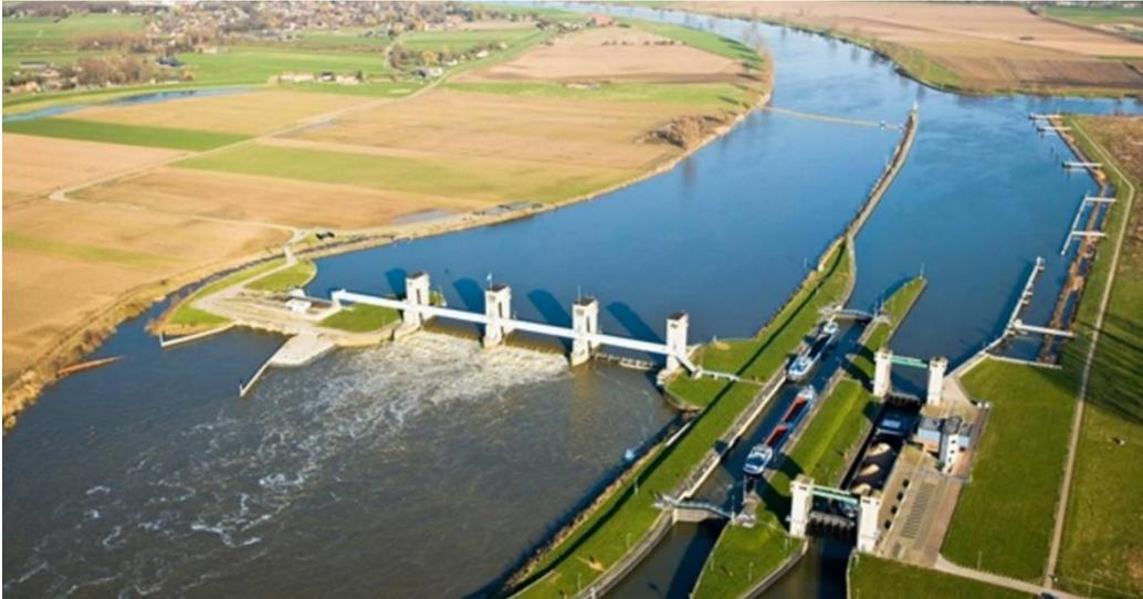
**Abbildung 7.** Stauhaltung bei Lith (Maas). An der linken Seite die Wasserkraftanlage und der Fischpass und an der rechten Seite die Schifffahrtsschleuse (Foto: Rijkswaterstaat).
