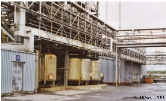
Lagerung fester Tanks
